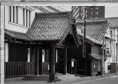
平成20年に竣工した本社事務所。白壁に古い向拝(p3参照)を組み合わせている。
