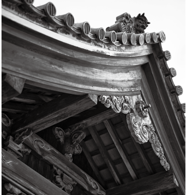
江戸時代、鹽竈神社の別当寺だった法蓮寺の向拝が、明治の廃仏毀釈の際に近隣地域の寺院の本堂に移築、さらに現在は鹽竈神社と関係の深かった佐浦の建物の玄関として移築活用されることになったもの。
